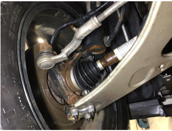
2.1 Overflaterust i forstilling, ingen tiltak kreves
