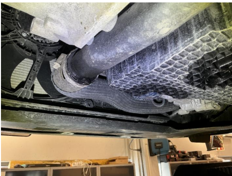
52. Utvendig tilstand motor
