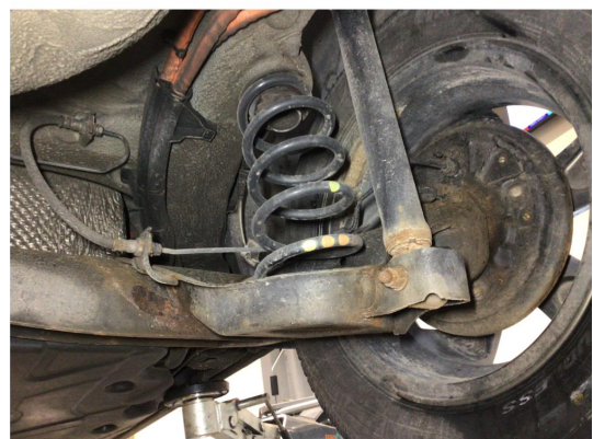
2.2 Overflaterust i bakstilling, ingen tiltak kreves
