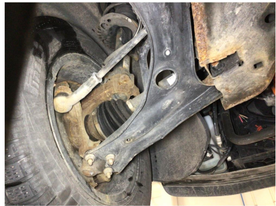
2.1 Overflaterust i forstilling/travers, ingen tiltak kreves
