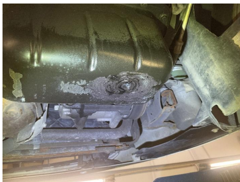
R 62. Utvendig tilstand motor
