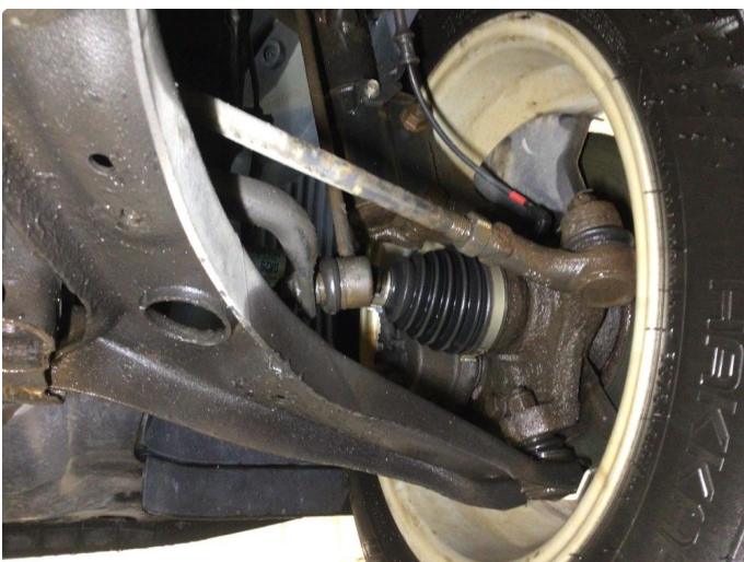
2.1 Overflaterust i forstilling, ingen tiltak kreves
