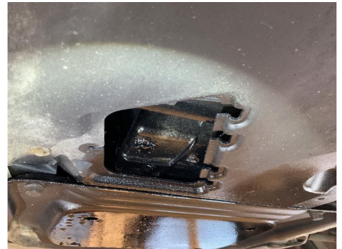
45. Utvendig tilstand motor
