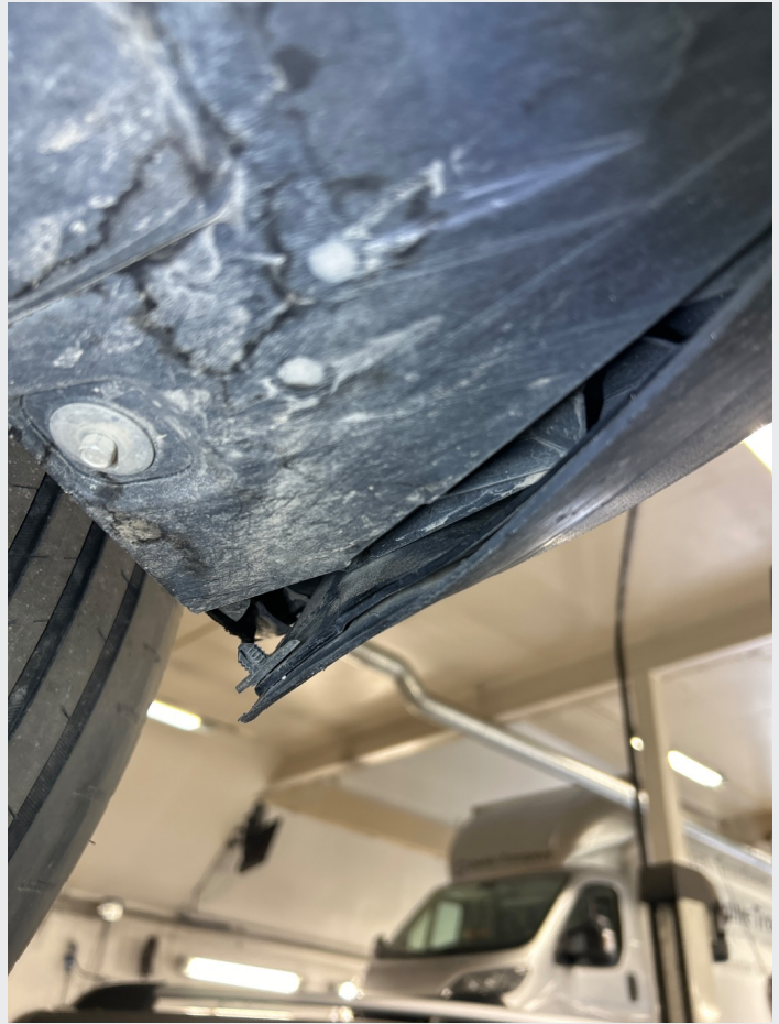
2.8 Bulk i nedre del av støtfanger foran
