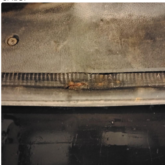
1.2 Løse/skadede lister. VURDERES VED SALG.
