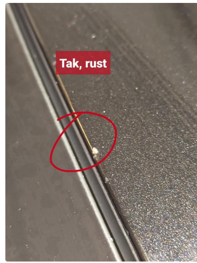
1.5 Steinsprut med rust
