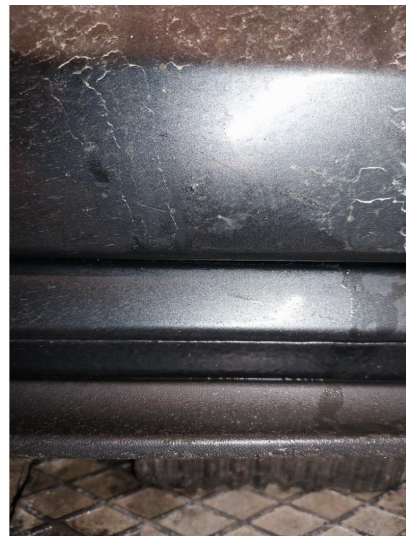
1.5 Steinsprut med rust
