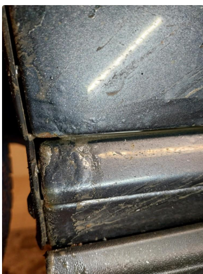
1.16 Korrosjon/rust
