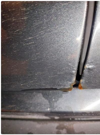
1.4 Steinsprut med rust
