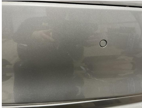
R 38. Støtfanger bak
