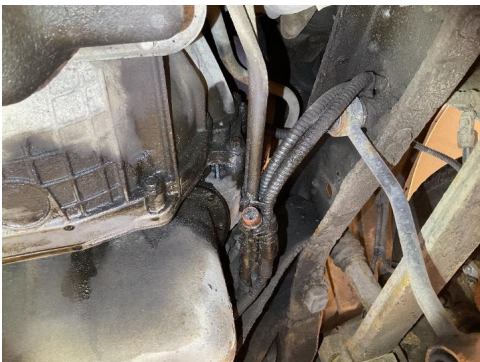
58. Utvendig tilstand motor.
