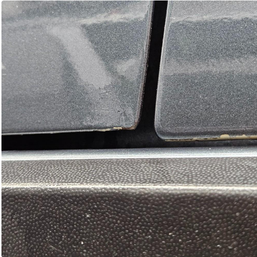
1.1 Noe antydning til korrosjon
