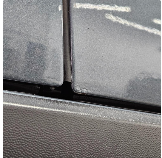
1.1 Noe antydning til korrosjon
