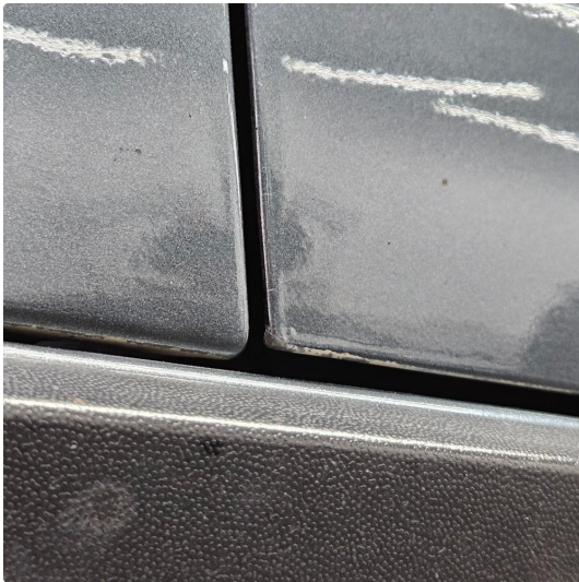
1.1 Noe antydning til korrosjon
