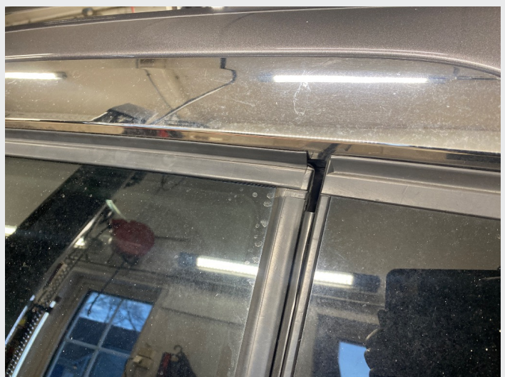
2.5 Mangler/knekt av gummi rundt dør venstre bak
