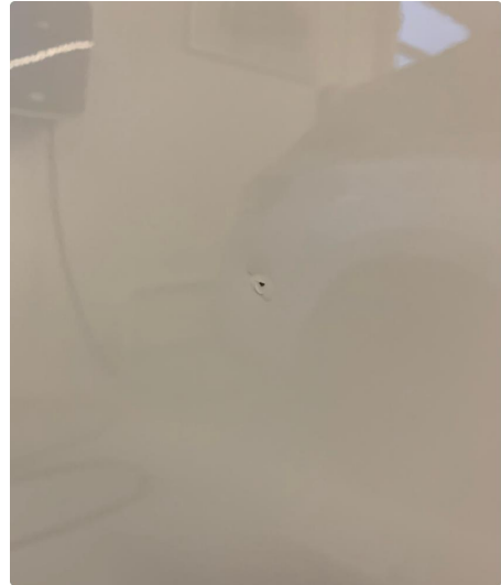
1.2 Lite lakksår på høyre skyvedør.
