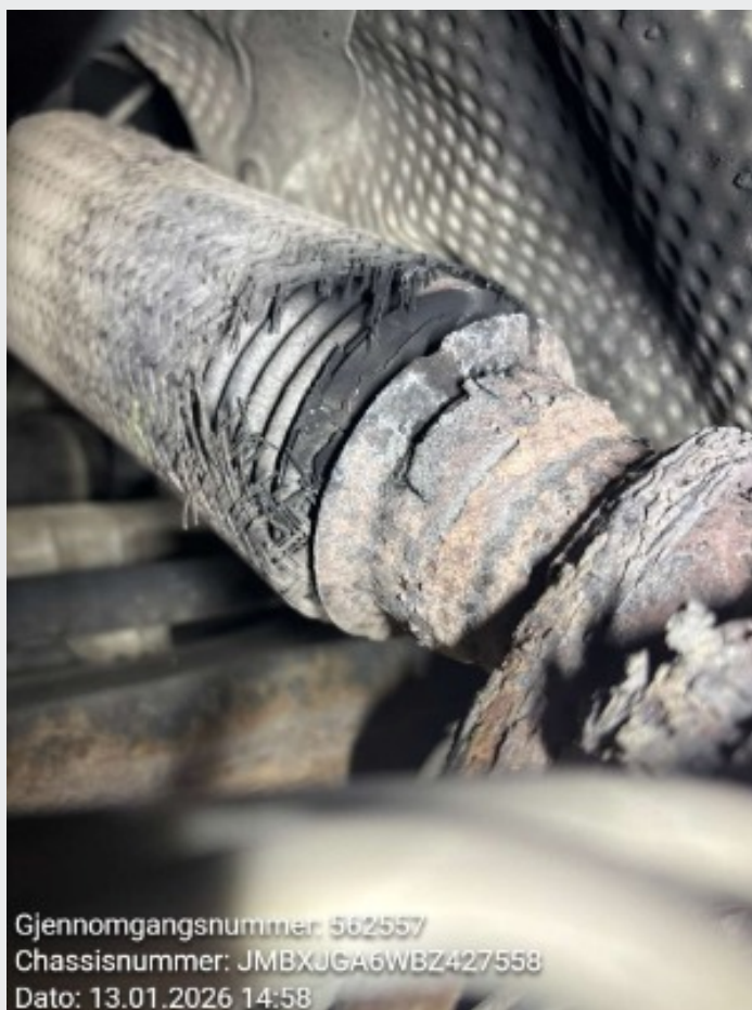
5.6 Lekkasje på flexirør
