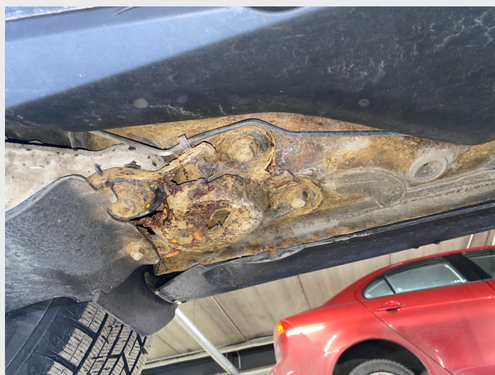
2.2 Rust under bil
