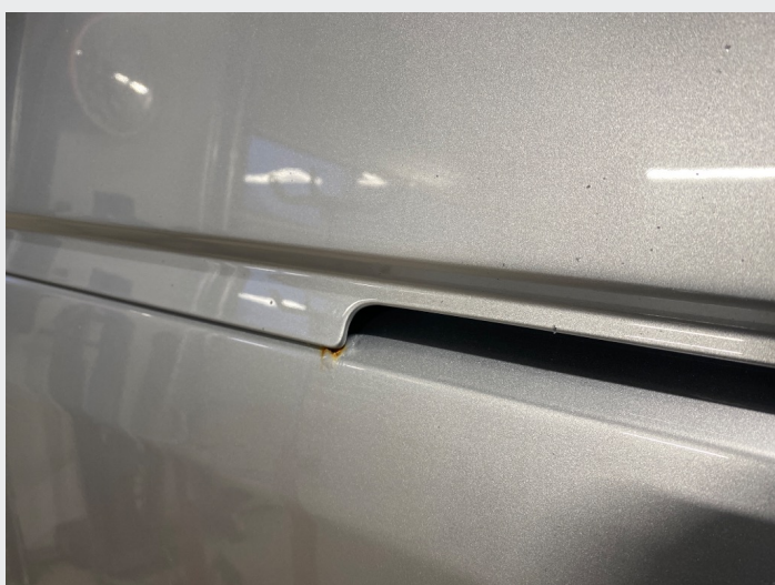
2.7 Påbegynt rust høyre bak
