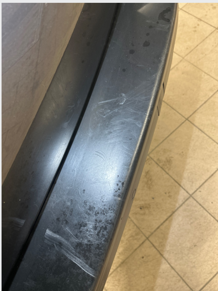
2.1 Noe steinsprut, riper og småbulker rundt om
