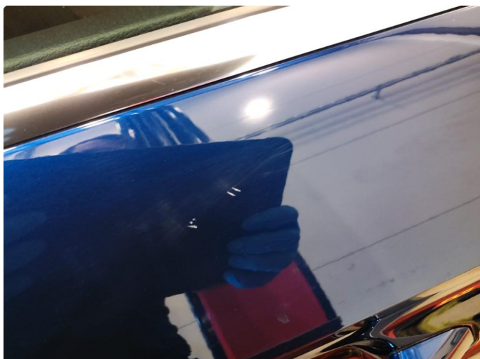
1.1 Ripe ned til grunning
