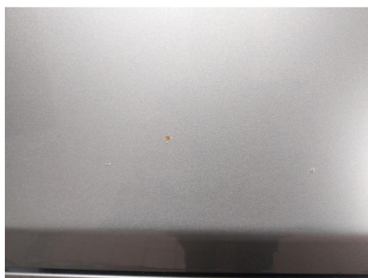
2.4 Rust/korrosjon
