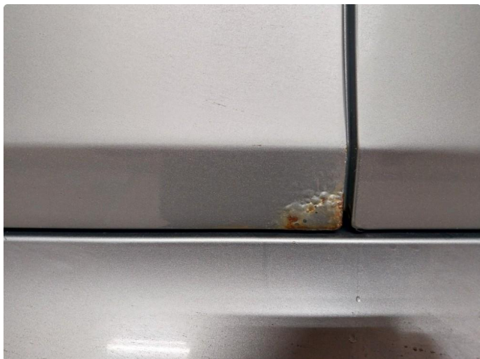
2.3 Rust i fals
