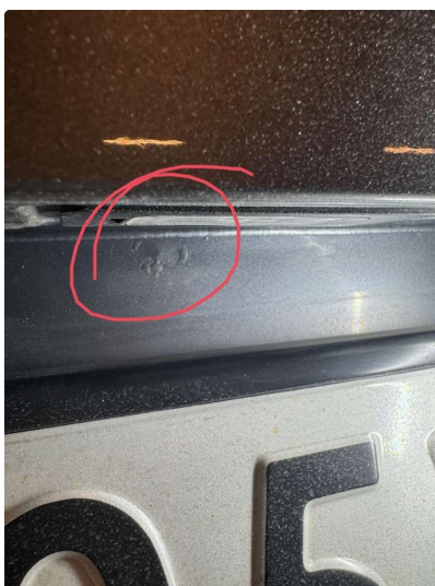
1.2 Rust/korrosjon blir utbedret før salg/ uke 2
