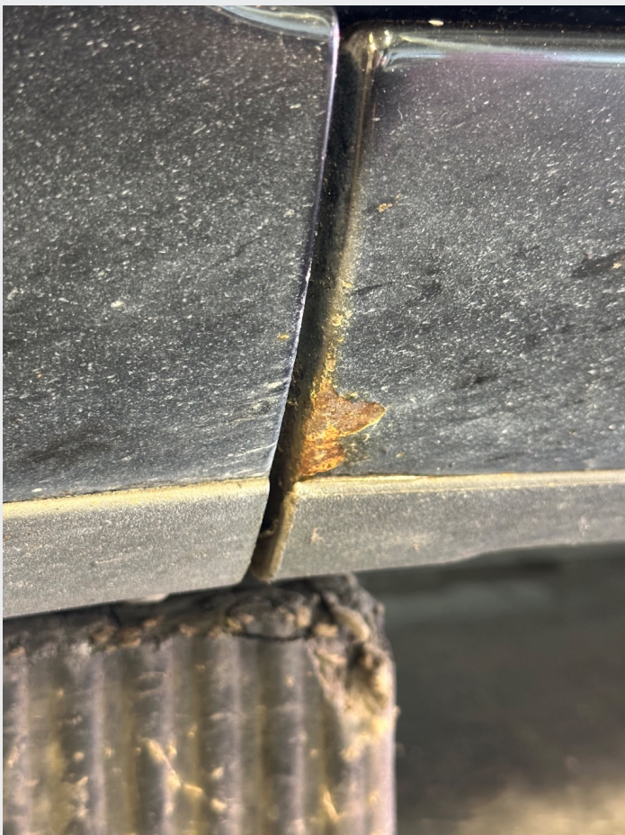
2.4 Rust kanaler bs
