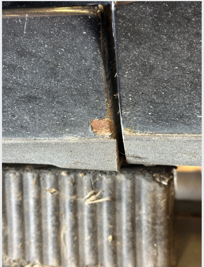
2.4 Rust kanaler bs
