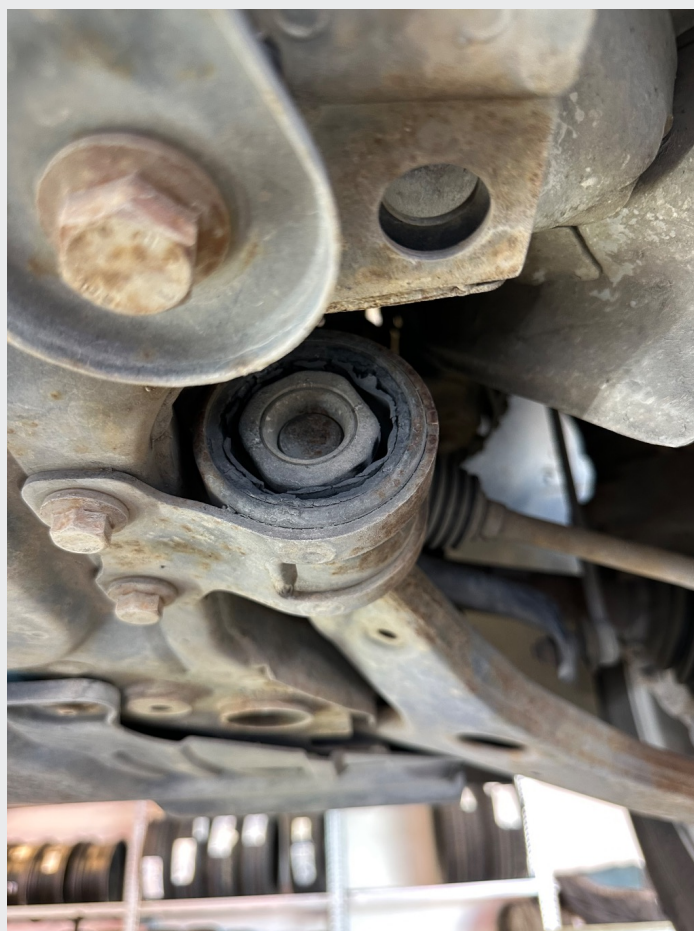
8.5 Bakre nedre bæreforinger ba foran holder på å slippe
