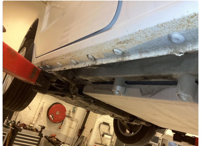
1.2 Påbegynnende overflaterust kanaler bs
