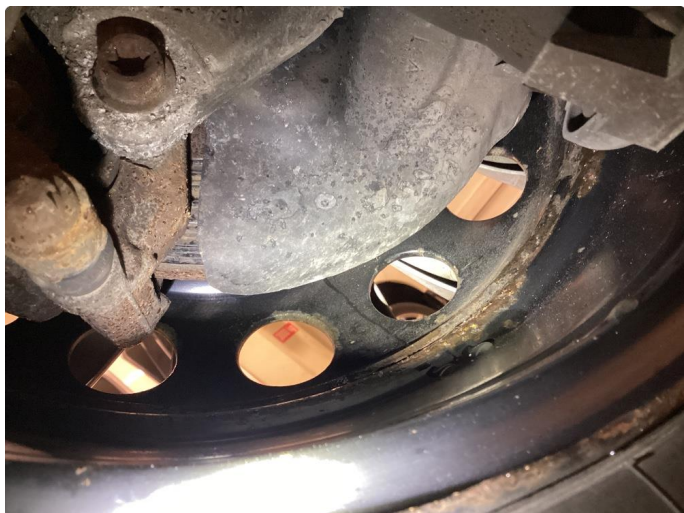
1.1 Rust inside skive vsb.
