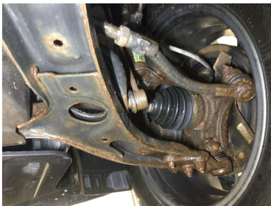
2.1 Overflaterust i forstilling, ingen tiltak kreves
