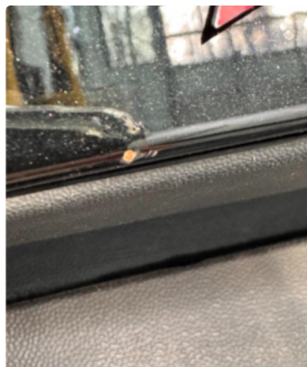
1.4 Liten steinsprut med korrosjon.
