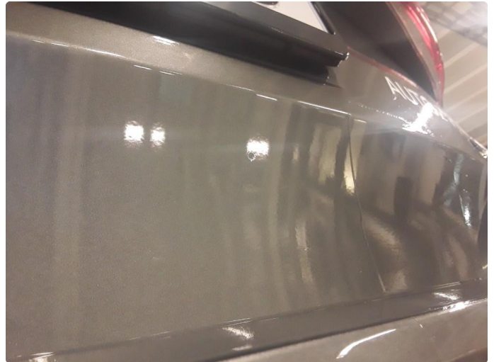
1.2 Liten steinsprut med korrosjon.
