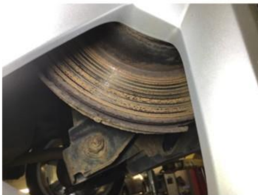
5.1 Noe rust på skiver foran og bak
