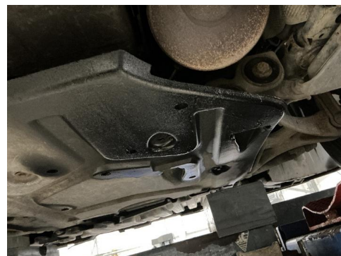
39. Utvendig tilstand motor
