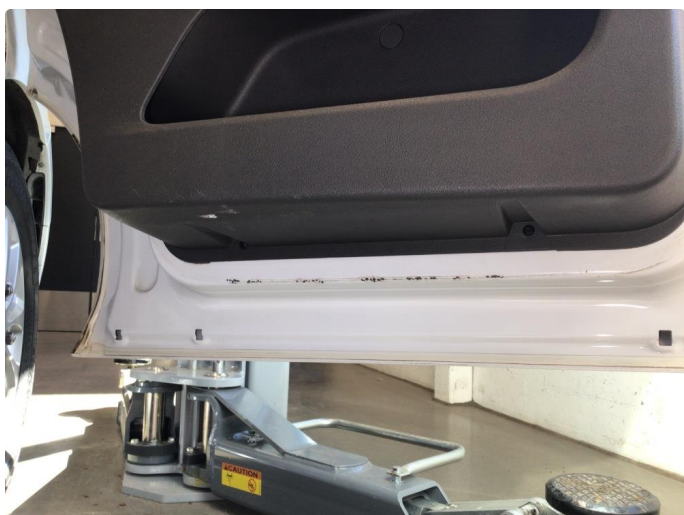
1.1 Noe korrosjon i høyre bakdør, høyre skyvedør og høyre framdør, dette av ubetydelig karakter
