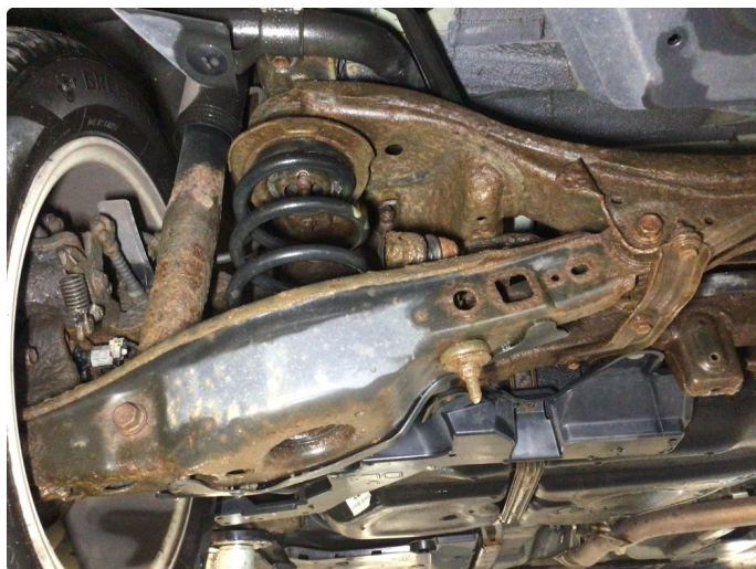
2.2 Overflaterust i bakstilling, ingen tiltak kreves
