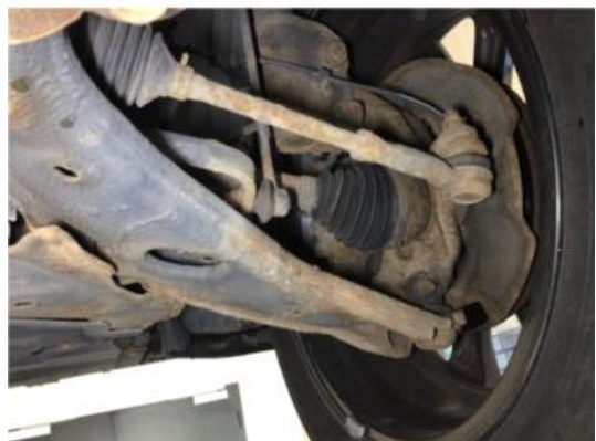
2.1 Overflaterust i forstilling, ingen tiltak kreves
