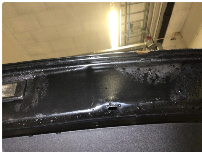
1.2 Noe korrosjon på innsiden av bakluke
