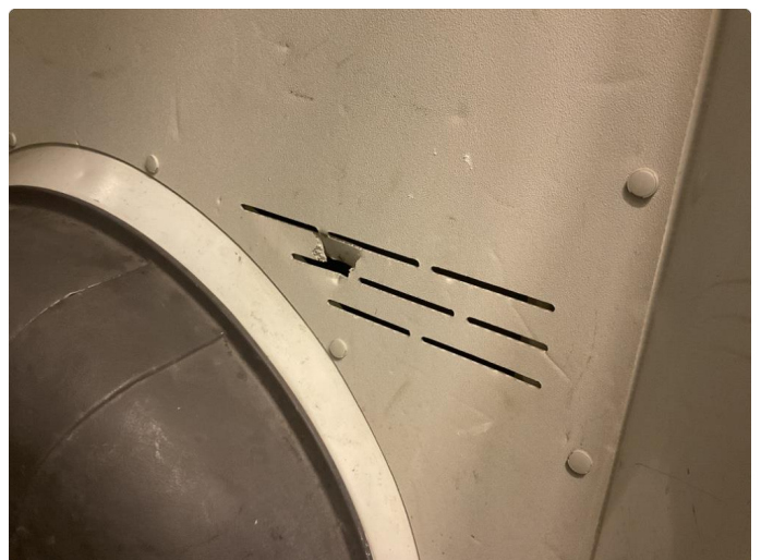
2.1 Deksler skadet/mangler
