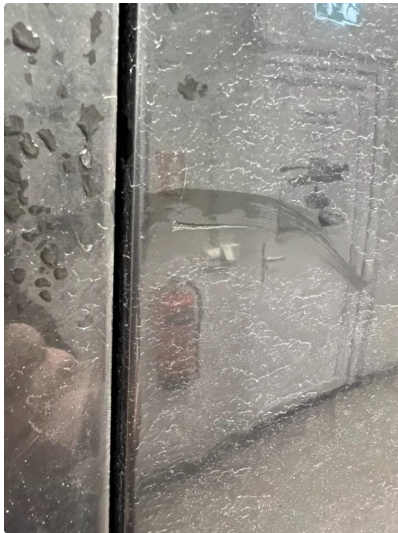
1.3 Ripe ned til grunning
