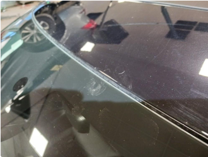
1.3 Ripe(r) ned til grunning
