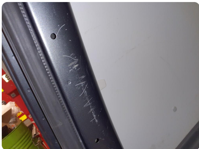
7.3 Øvrige feil Generell bruksslitasje. Inkluderer noe riper, små skader mm.
