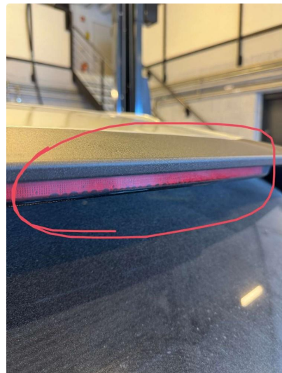
2.1 Dugg/fukt, blir utbedret 14/10
