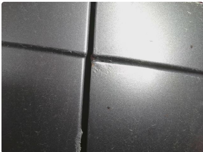
1.3 Rust/korrosjon
