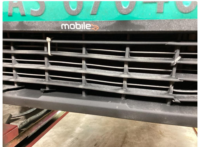
1.2 Sprukket- Blir reparert før salg
