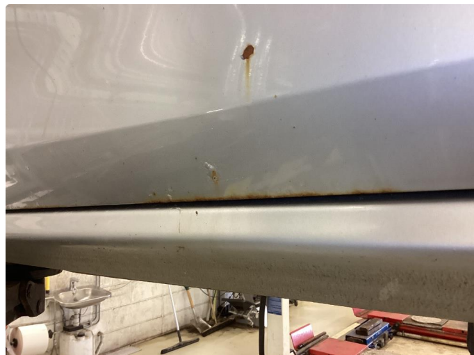
1.1 Rust i fals
