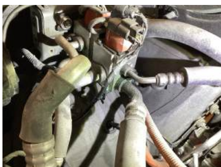
7. Varmeapparat / klimaanlegg (AC)
