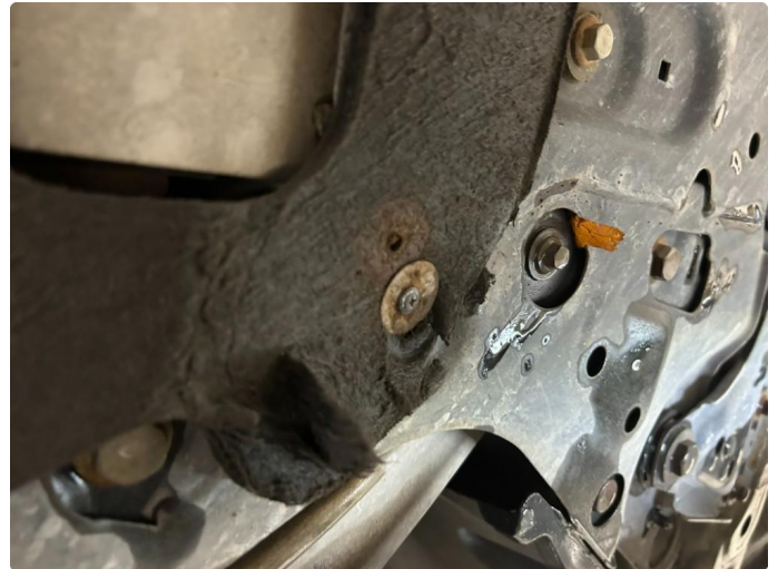
1.1 Beskyttelsesplate skadet/mangler (festet med karosseriskrue)
