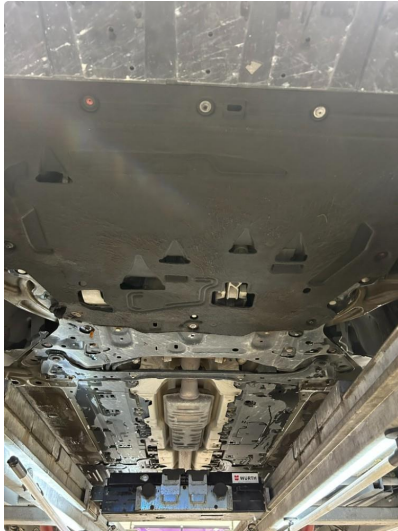
1.1 Beskyttelsesplate skadet/mangler (festet med karosseriskrue)
