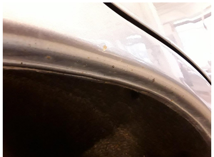
1.5 Bulk med korrosjon.
