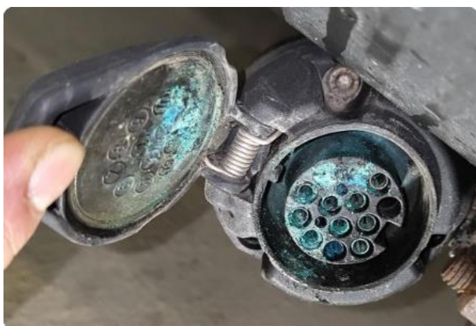
1.5 Betydelig korrosjon i hengerfeste kontakt
