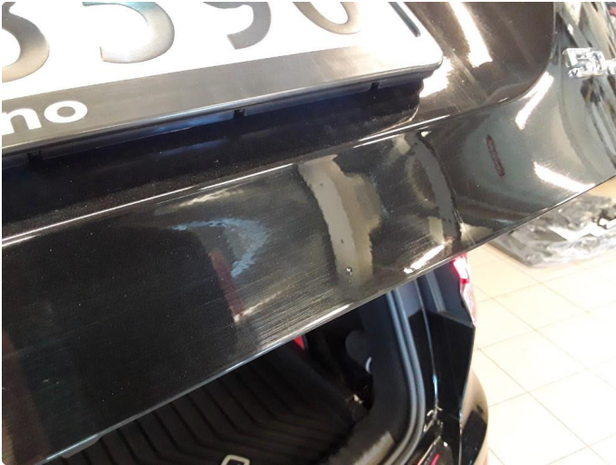
1.2 Liten steinsprut med korrosjon.
