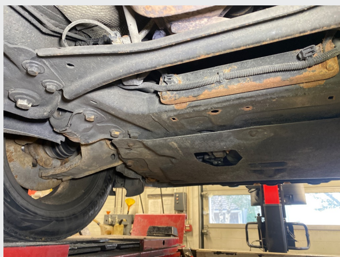
8.5 Det finnes rust i for og bakstilling
