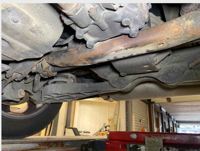
8.5 Det finnes rust i for og bakstilling
