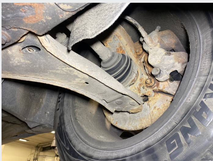
8.5 Det finnes rust i for og bakstilling
