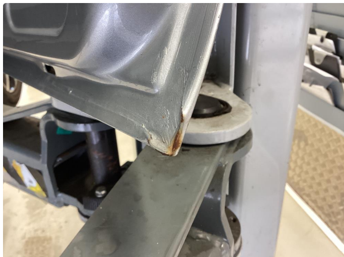
1.1 Rust i fals
