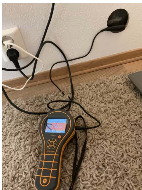
Fuktmåling Hull 1 under befaring
